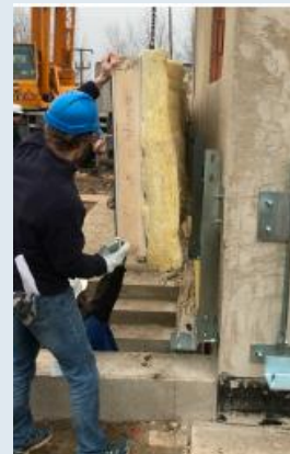
Paveikslas 4-12. Skydų montavimas (Šaltinis: MORE-CONNECT
