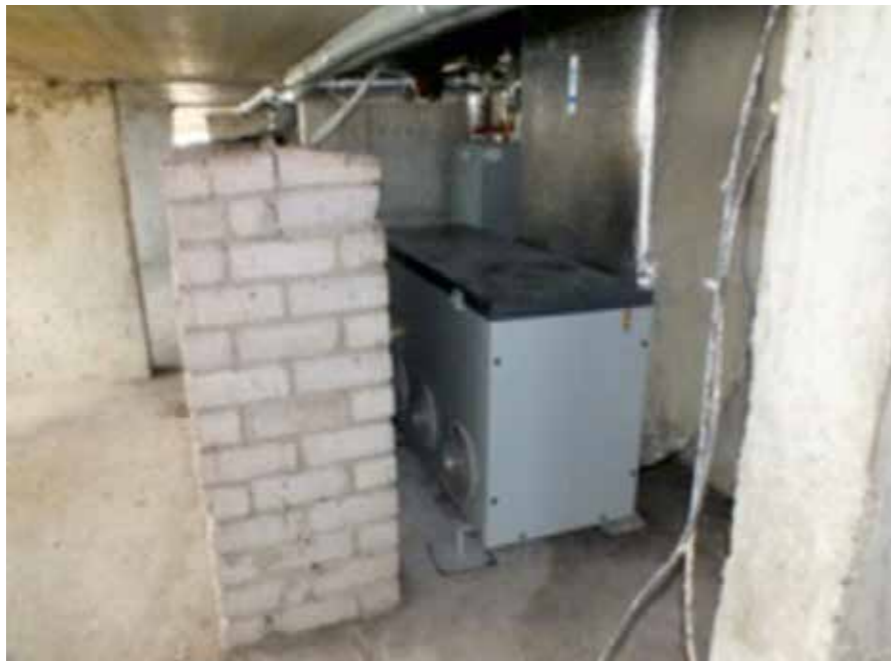
3.9 pav. Daugiabučio pastato pastogėje šalia natūralaus vėdinimo šachtos sumontuotas šilumos siurblys oras–vanduo [30]
