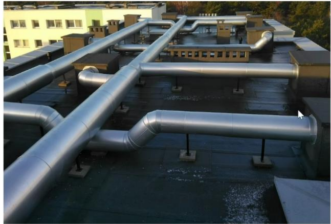
13 pav. Vėdinimo vamzdynai ant plokščio stogo
