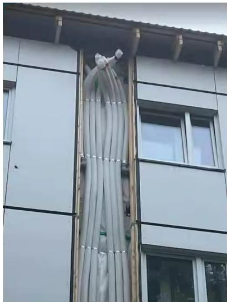
18 pav. Vėdinimo vamzdynai sienoje, šiltinimo sluoksnyje
