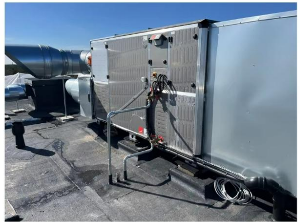
14 pav. Rekuperatoriai ant plokščio stogo
