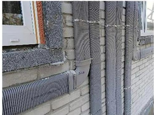
10 pav. Plokščias, elastingas vėdinimo ortakis tvirtinamas ant fasado, po šiltinimo sluoksniu
