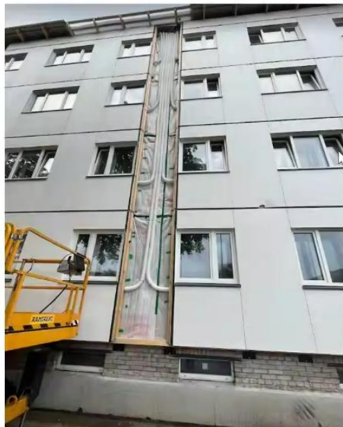
18 pav. Vėdinimo vamzdynai sienoje, šiltinimo sluoksnyje
