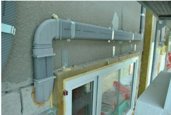
10 pav. Plokščias, elastingas vėdinimo ortakis tvirtinamas ant fasado, po šiltinimo sluoksniu
