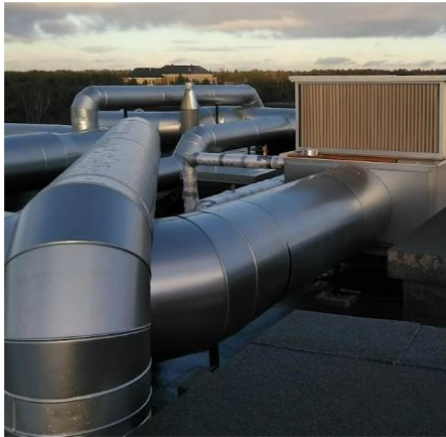
13 pav. Vėdinimo vamzdynai ant plokščio stogo
