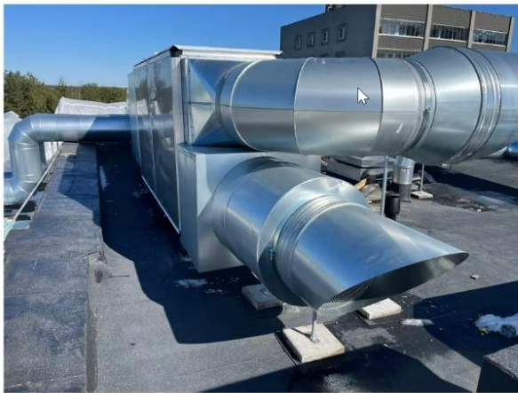
14 pav. Rekuperatoriai ant plokščio stogo
