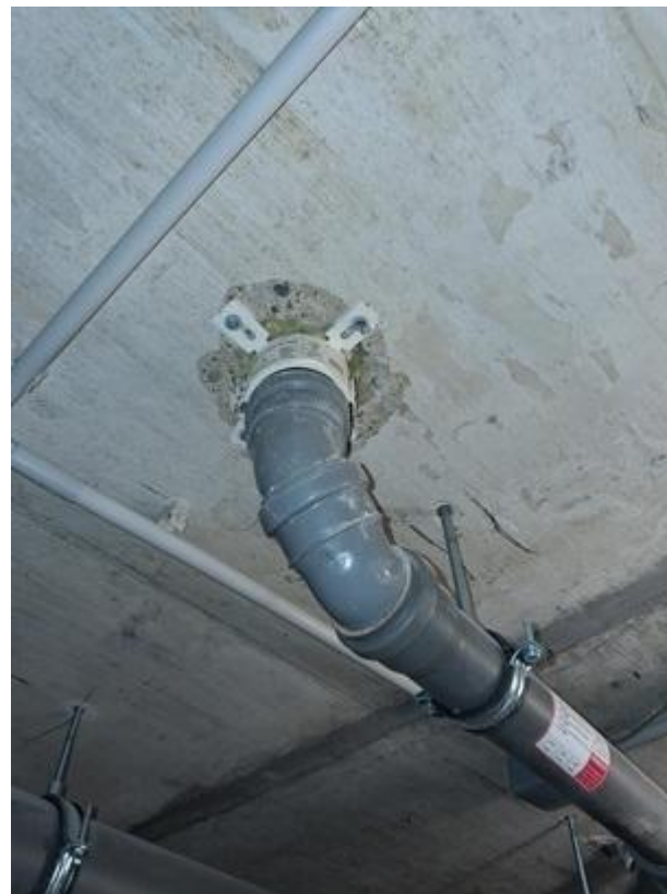
pav. 10. Netinkamas priešgaisrinių reikalavimų įgyvendinimo pavyzdys, netinkamas sandarinimas tuščios ertmės pripūstos montažinėmis putomis.
