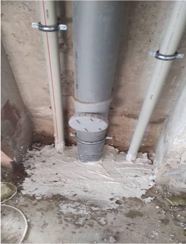
pav. 11. Tinkamas priešgaisrinių reikalavimų įgyvendinimo pavyzdys, tinkamai užsandarintas vamzdis.
