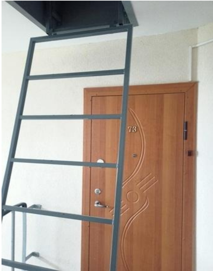
pav. 1. Netinkamas priešgaisrinių reikalavimų įgyvendinimo pavyzdys, nes užstatomas evakuacinis išėjimas.
