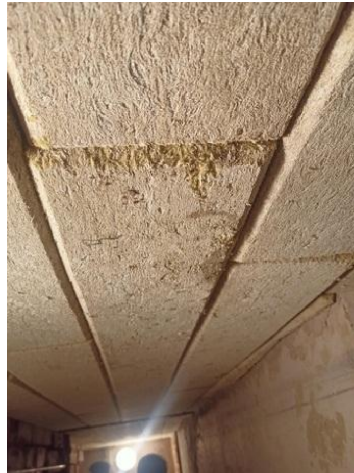
pav. 2. Tinkamas priešgaisrinių reikalavimų įgyvendinimo pavyzdys, apšiltinant rūsio perdangą.
