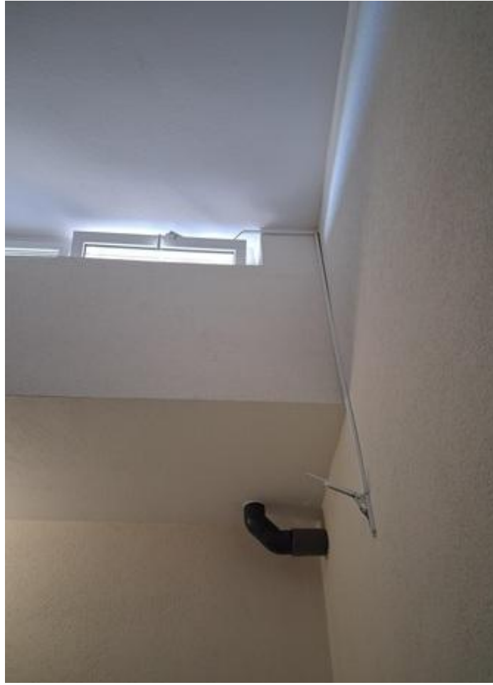
pav. 4. Tinkamas priešgaisrinių reikalavimų įgyvendinimo pavyzdys, lango dūmams išleisti atidarymo mechanizmas įrengtas tinkamai.
