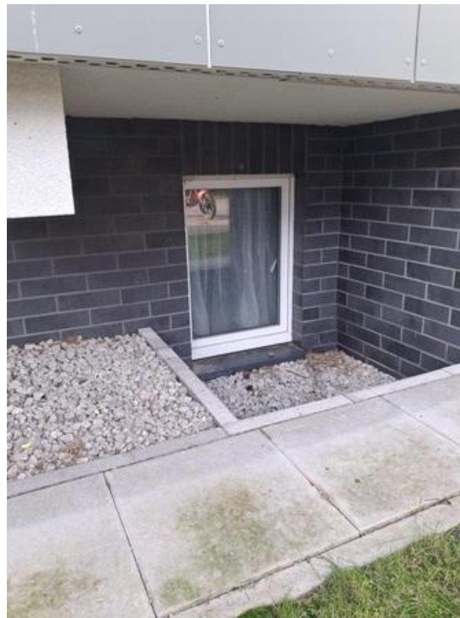
pav. 16. Kairėje pusėje - rūšio langas dūmams išleisti užtvertas durimis iš vidinės pusės, dešinėje - tinkamas pavyzdys: durys pašalintos.
