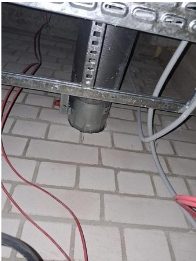
pav. 14. Netinkamas priešgaisrinių reikalavimų įgyvendinimo pavyzdys, sandarinimas neatliktas.
