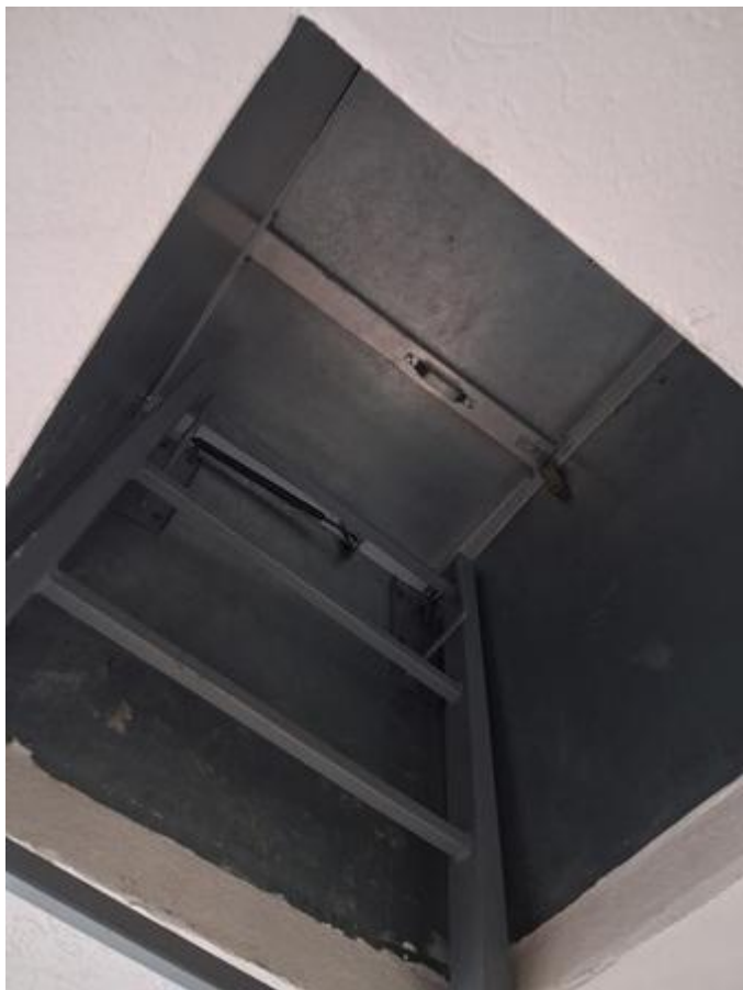
pav. 7. Tinkamas priešgaisrinių reikalavimų įgyvendinimo pavyzdys, tinkamo dydžio anga.
