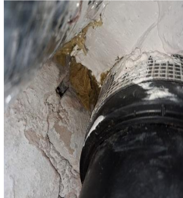
pav. 13. Netinkamas priešgaisrinių reikalavimų įgyvendinimo pavyzdys: blogas sandarinimas - priešgaisrinė juosta įrengta ne standžioje terpėje (skiedinyje), trūksta priešgaisrinio skiedinio.
