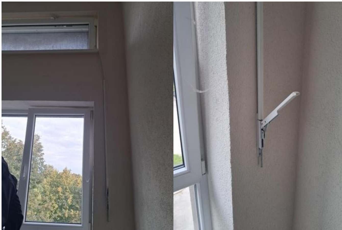
pav. 5. Tinkamas priešgaisrinių reikalavimų įgyvendinimo pavyzdys, lango dūmams išleisti atidarymo mechanizmas įrengtas tinkamai.
