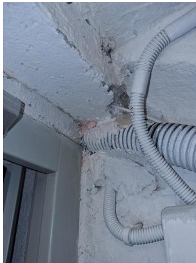
pav. 15. Netinkamas priešgaisrinių reikalavimų įgyvendinimo pavyzdys, netinkamas sandarinimas naudojant montazines putas.
