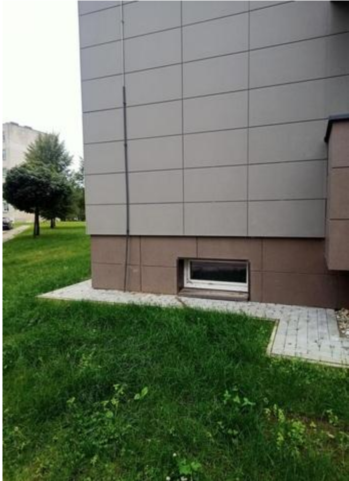
pav. 3. Apsaugos nuo žaibo įžeminimo laidininkai turi būti tiesiami kuo didesniu galimu atstumu nuo durų ir langų, bet ne arčiau kaip 2 m. Kai neįmanoma užtikrinti šio atstumo, įžeminimo laidininkai turi būti tiesiami A1 arba A2 degumo klasės vamzdžiuose. Tačiau praktikoje šiuo metu nėra sertifikuotų vamzdžių, turinčių eksploatacinių savybių deklaracijas ir atitinkančių A1 ar A2 degumo klases, todėl įžeminimo laidininkai faktiškai tiesiami arčiau kaip 2 m nuo langų.
