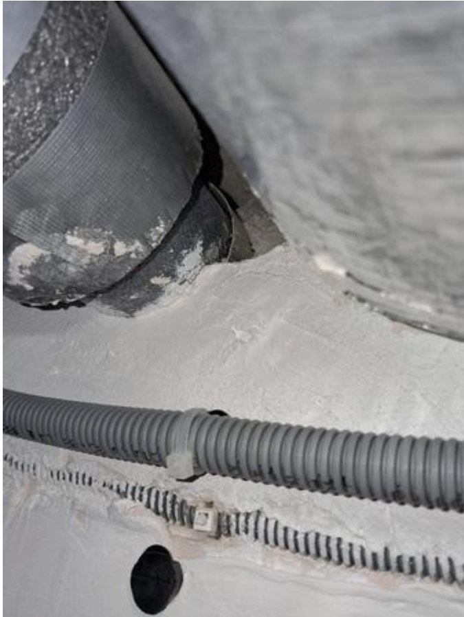
pav. 12. Netinkamas priešgaisrinių reikalavimų įgyvendinimo pavyzdys, vamzdis kartu su termoizoliacija netinkamai kerta priešgaisrinę užtvartą per gilžę - sandarinimas neatliktas.
