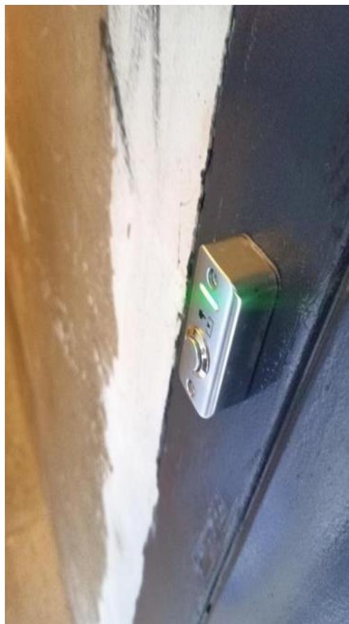
pav. 8. Elektromagnetinė spyna įrengta tinkamai, tačiau būtina atlikti bandymą, vertinant jos veikimą gaisro metu.
