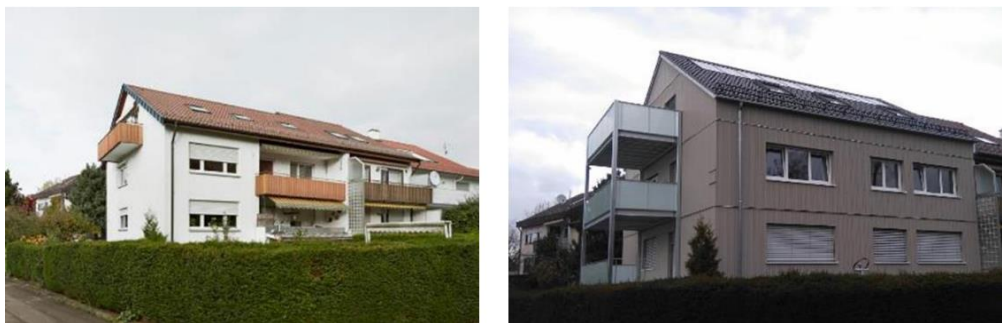
2.4 pav. Skydais apšiltintas 8 butų pastatas, kairėje – vaizdas prieš renovaciją, dešinėje – po renovacijos 9
