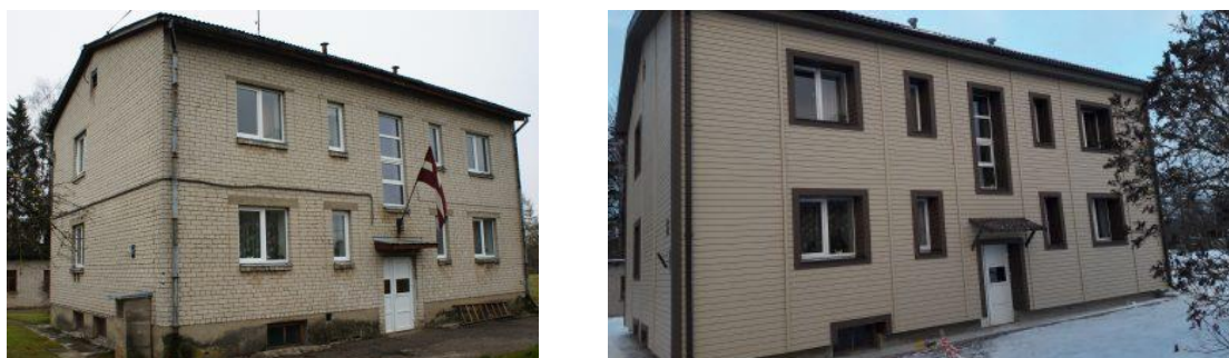
2.6 pav. Skydais apšiltintas 200 m 2 ploto pastatas, kairėje – vaizdas prieš renovaciją, dešinėje – po renovacijos 11
