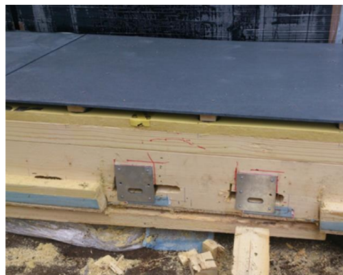
7.4. Įdėtinės detalės skyde skydo tvirtinimui 59
