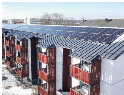
2.8 pav. Pastato lodžių ir balkonų renovacijos sprendimas taikant skydinę technologiją su pristatomais balkonais, kairėje – vaizdas prieš renovaciją, dešinėje – po renovacijos 13
