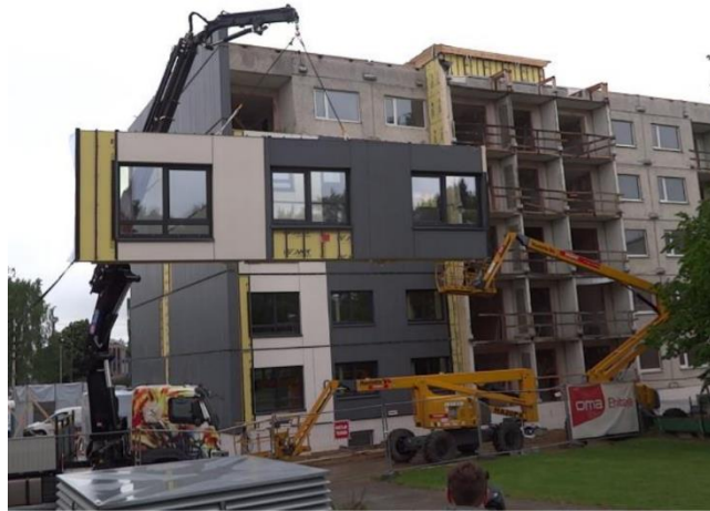
2.2 pav. Sienos apšiltinimo skydo montavimas daugiabučio gyvenamojo namo fasade Estijoje 7
