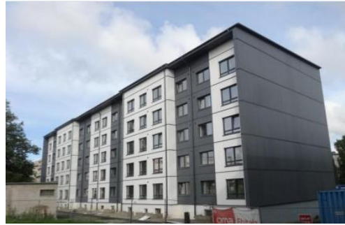
2.7 pav. Skydais apšiltintas 80 butų pastatas, kairėje – vaizdas prieš renovaciją, dešinėje – po renovacijos 12
