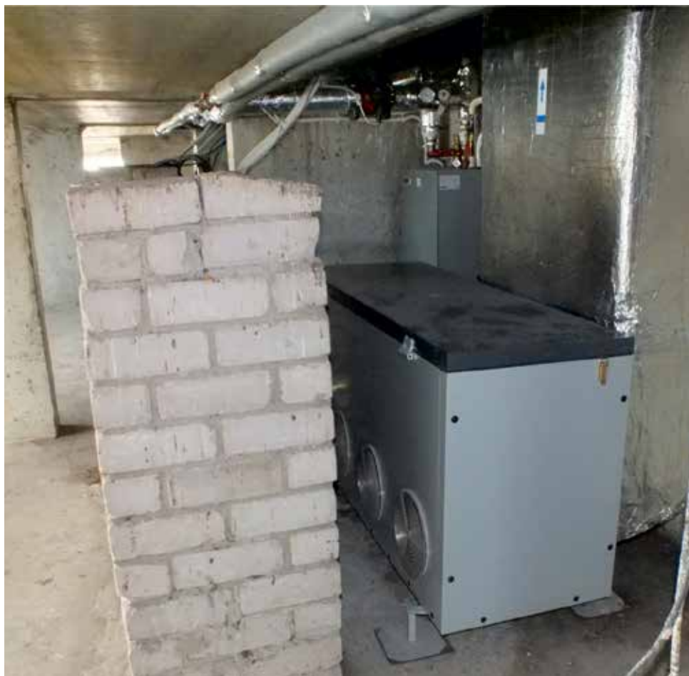
13.21 pav. Daugiabučio pastato pastogėje šalia natūralaus vėdinimo šachtos sumontuotas šilumos siurblys „oras-vanduo“
