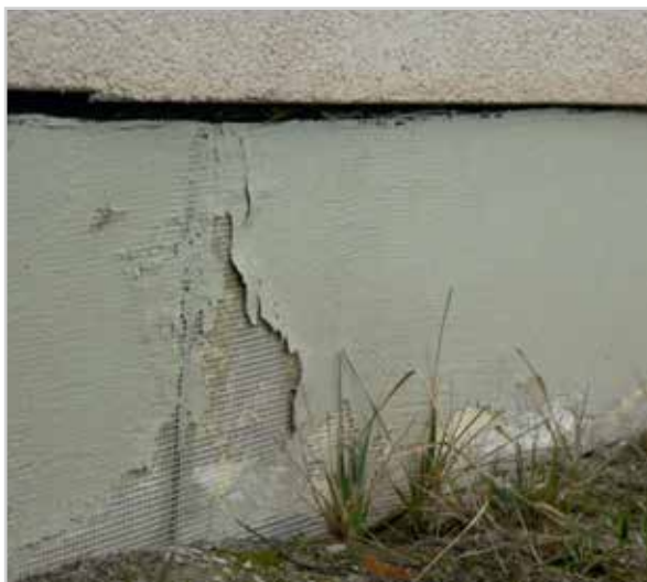
5.1 pav. Gendantis naujai apšiltintas cokolis ties neįrengta nuogrinda
