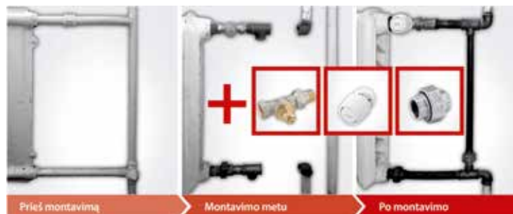
11.13 pav. Šildymo prietaiso prijungimo algoritmas vienvamzdėje šildymo sistemoje [55]
