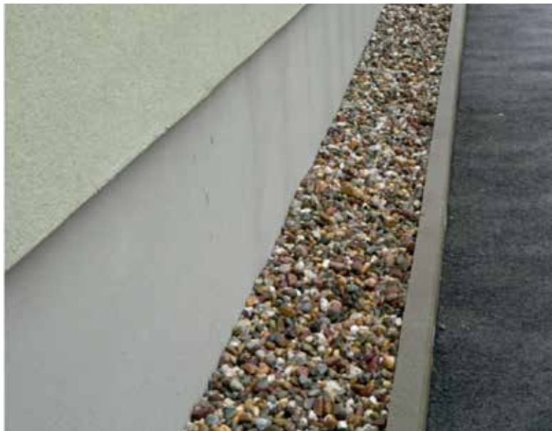
5.6 pav. Tinkuotas cokolis ties kokybiška atvira vėdinama ir drenuojama nuogrinda
