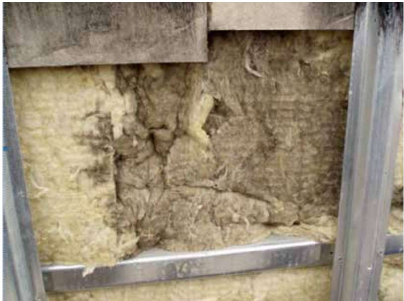
7.12 pav. Užterštos ir įdrėkusios vėdinamos šiltinimo sistemos su atviromis horizontaliomis siūlėmis fragmentas.
