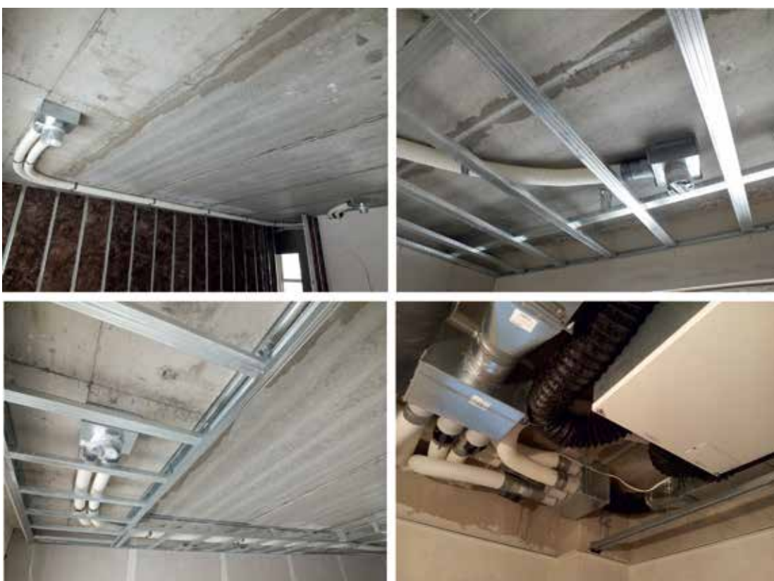
13.17 pav. Decentralizuota mechaninė vėdinimo sistema su šilumos rekuperacija montavimo metu (naudojami lankstūs plastikiniai ortakiai)
