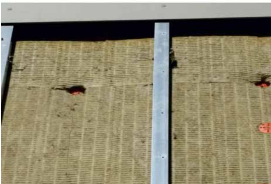
7.10 pav. Smeigėmis neleistinai deformuota ir suardyta mineralinės vatos struktūra
