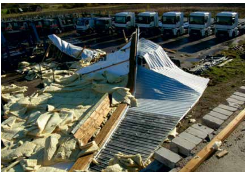
10.3 pav. Vėtros suardytas nepakankamai sutvirtintas šlaitinis stogas
