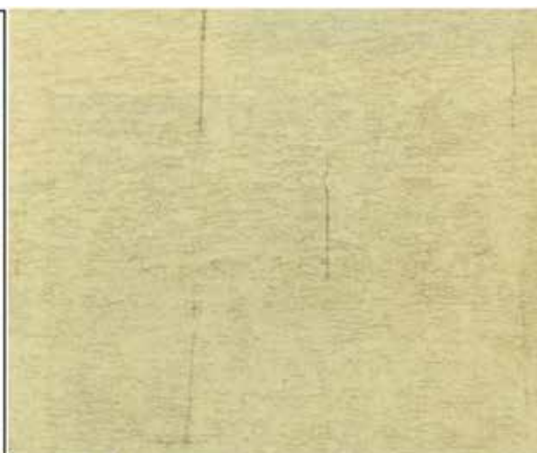
7.4 pav. Nekokybiškai priklijuotos šiltinimo sistemos deformacijos ir pleišėjimai
