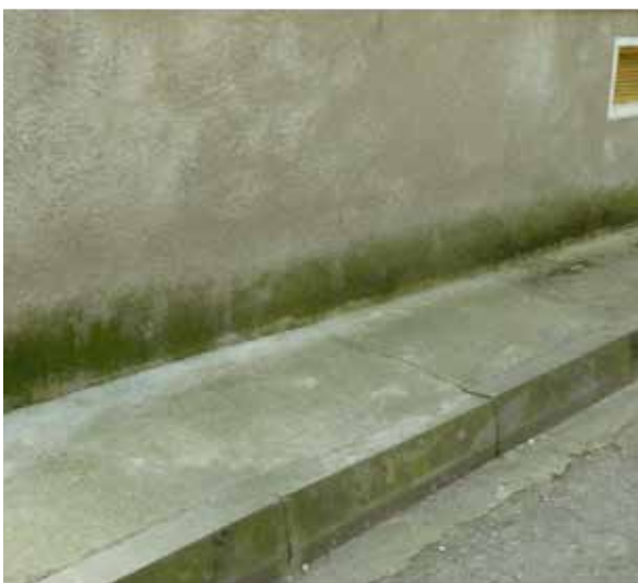
5.2 pav. Gendantis naujai įrengtas cokolis ties uždara betonine nuogrinda
