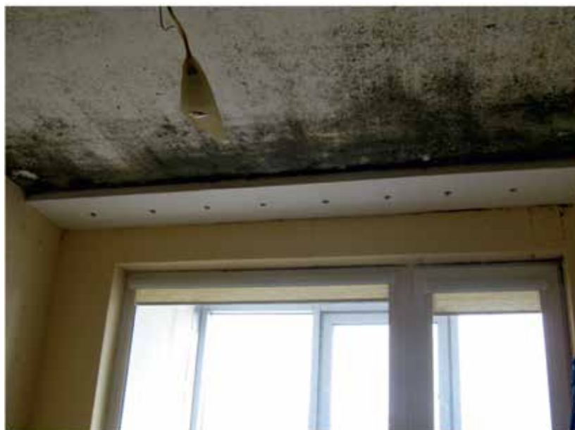
10.1 pav. Gyvenamosios patalpos lubos po nekokybiškai apšiltintu stogu
