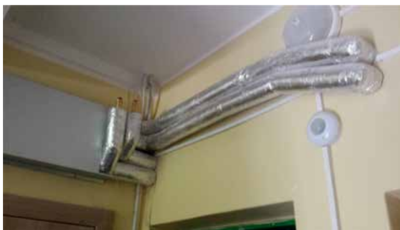
11.41 pav. Sumontuota kolektorinė šildymo sistema
