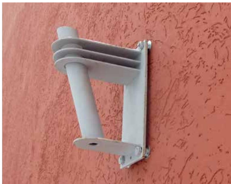
7.9 pav. Teisingai pritvirtintos vėliavos laikiklio variantas
