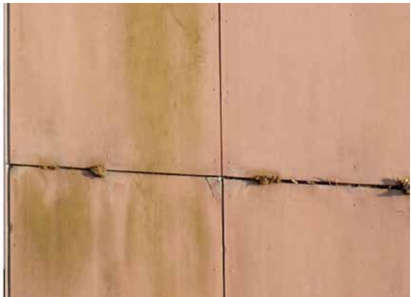
7.13 pav. Akivaizdžiai gendantis fasadas su atviromis horizontaliomis siūlėmis
