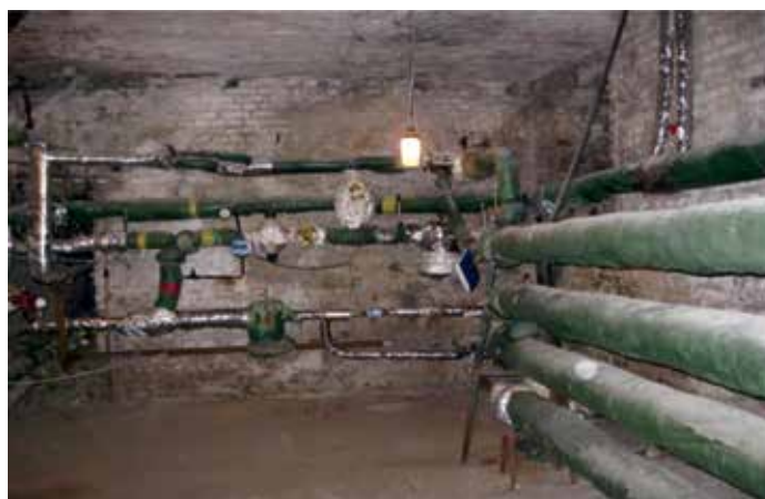
12.5 pav. Senas elevatorinis šilumos punktas su vamzdeliniu šilumokaičiu
