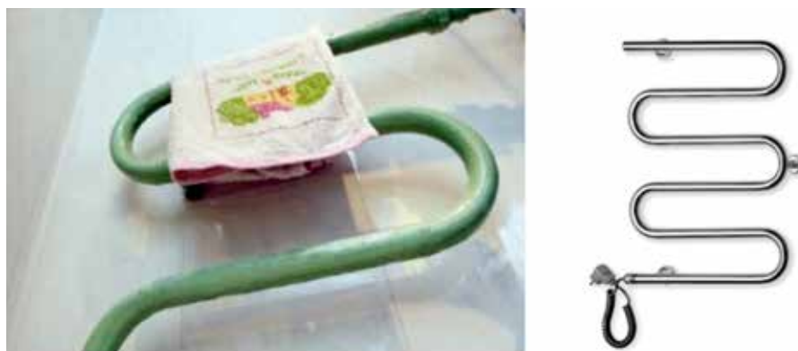
11.49 pav. Seno ir naujo tipo gyvatukai
