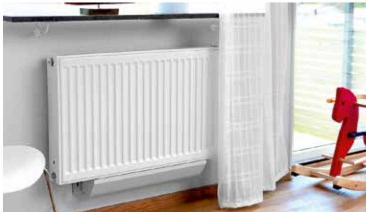
13.10 pav. Su vandeniniais radiatoriais kombinuojama hibridinė vėdinimo sistema
