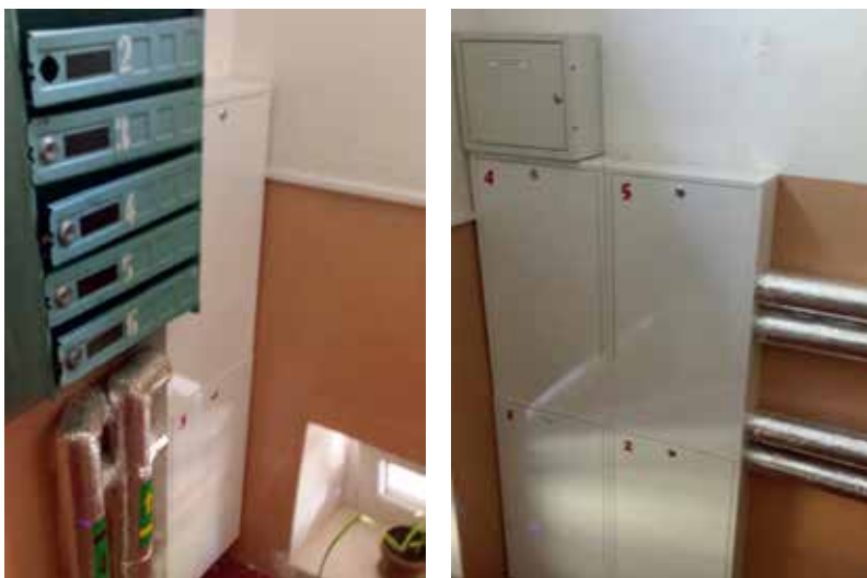
11.40 pav. Sumontuota kolektorinė šildymo sistema
