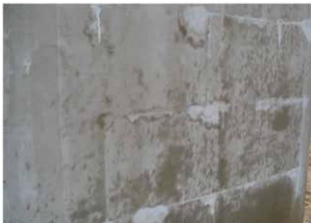
7.3 pav. Naujai nutinkuoto fasado fragmentas ties nekokybiškai priklijuotomis šiltinimo plokštėmis
