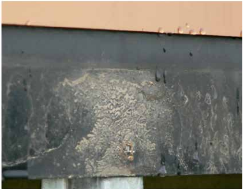
7.11 pav. Užteršta šiltinimo sistemos jungtis.
