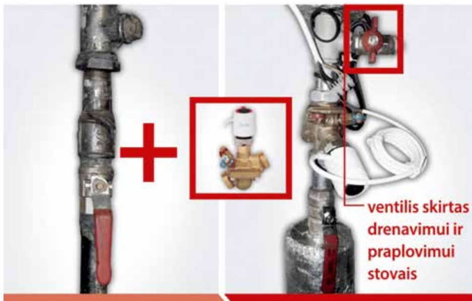
11.20 pav. Automatinio balansavimo ventilio montavimas
