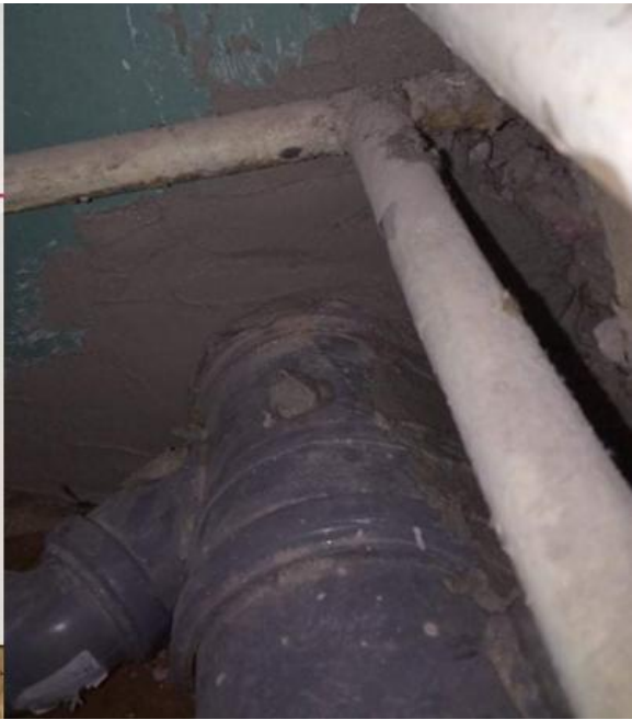
Netinkamas priešgaisrinių reikalavimų įgyvendinimo pavyzdys: buvo panaudota ne ta medžiaga, kurios dokumentai buvo pateikiami
