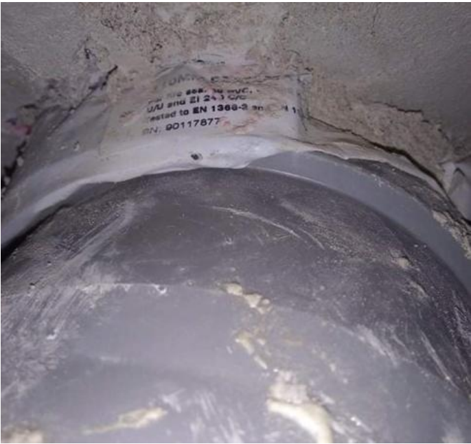
Tinkamas priešgaisrinių reikalavimų įgyvendinimo pavyzdys, įrengta sandarinimo juosta ir tinkamai užsandarintas vamzdis
