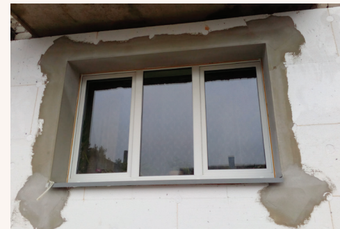
Tinkamai sukljuotos šiltinimo plokštės
